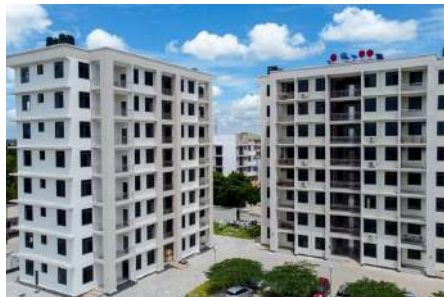
Ujenzi wa Nyumba za Makazi Magomeni Kota mkoani Dar es salaam
