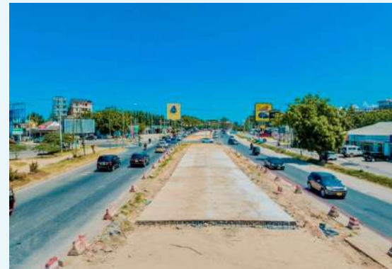
Kazi za ujenzi wa Barabara ya Mabasi yaendayo haraka Awamu ya Nne (BRT IV) ukiendelea mkoani Dar es Salaam.
