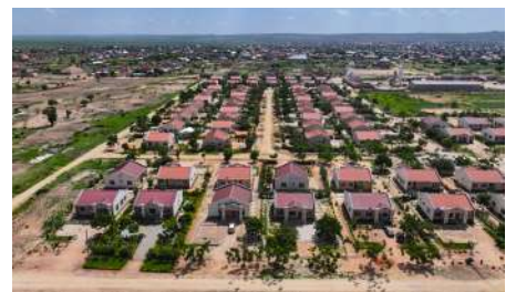
Mradi wa ujenzi wa nyumba za Makazi za Watumishi wa Umma eneo la Nzuguni 'B', mkoani Dodoma.
