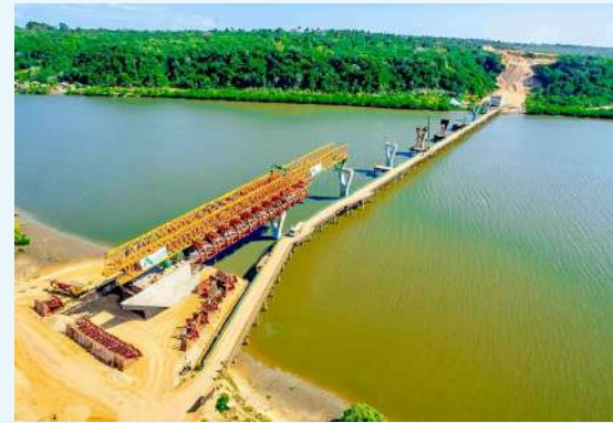
Ujenzi wa Daraja la Pangani lenye urefu wa mita 525 na Barabara unganishi zenye urefu wa Kilomita 25 ukiendelea.
